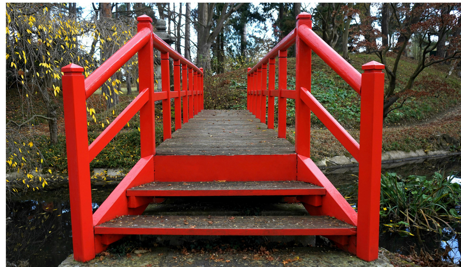
Un ponte che unisce città e provincia
