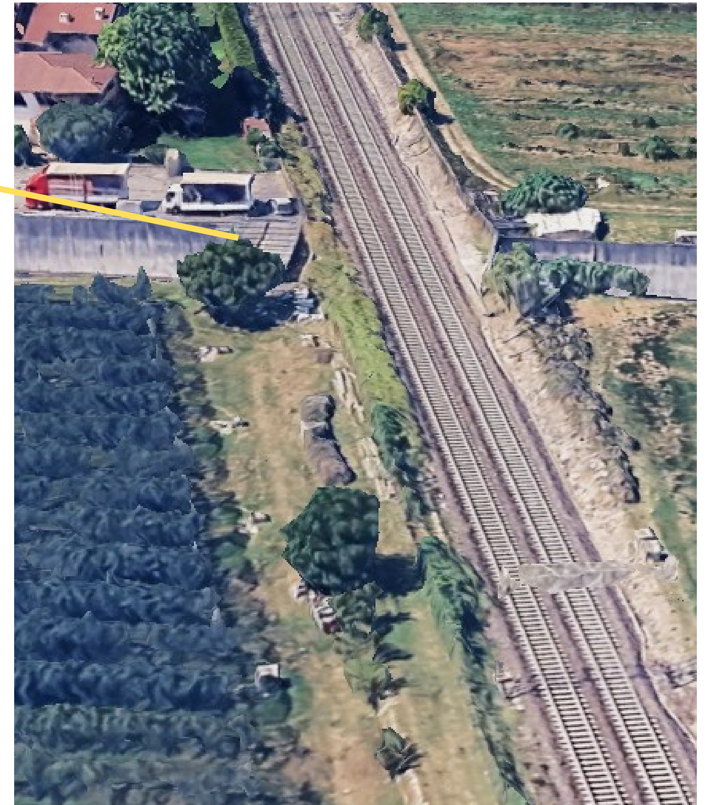
Il passaggio sopra Strada del Chiodo
